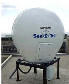
Figura 3. Antena receptora del sensor AVHRR en formato HRPT
