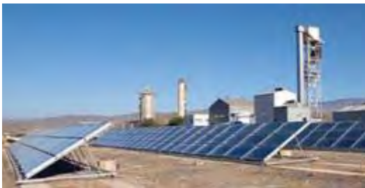
Campo de captadores solares estáticos (606 m 2 ) para desalación y módulos de destilación por membranas.
