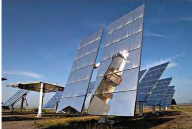
Vista de la torre del CESA-1 reflejada en un helióstato
