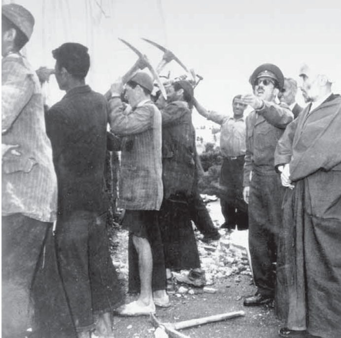
Mullá Falsafi supervisa a los trabajadores que destruyen la cúpula del Centro Nacional bahá'í, hecho ocurrido en 1955, en Teherán.
