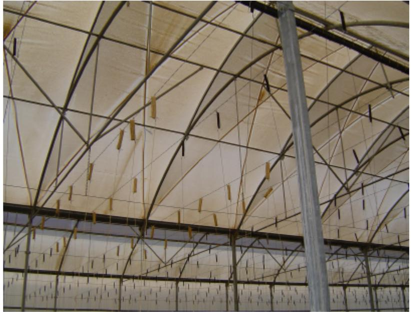
**Figura 7: Detalle de las cintas de poliéster que protegen la cubierta plástica.**
