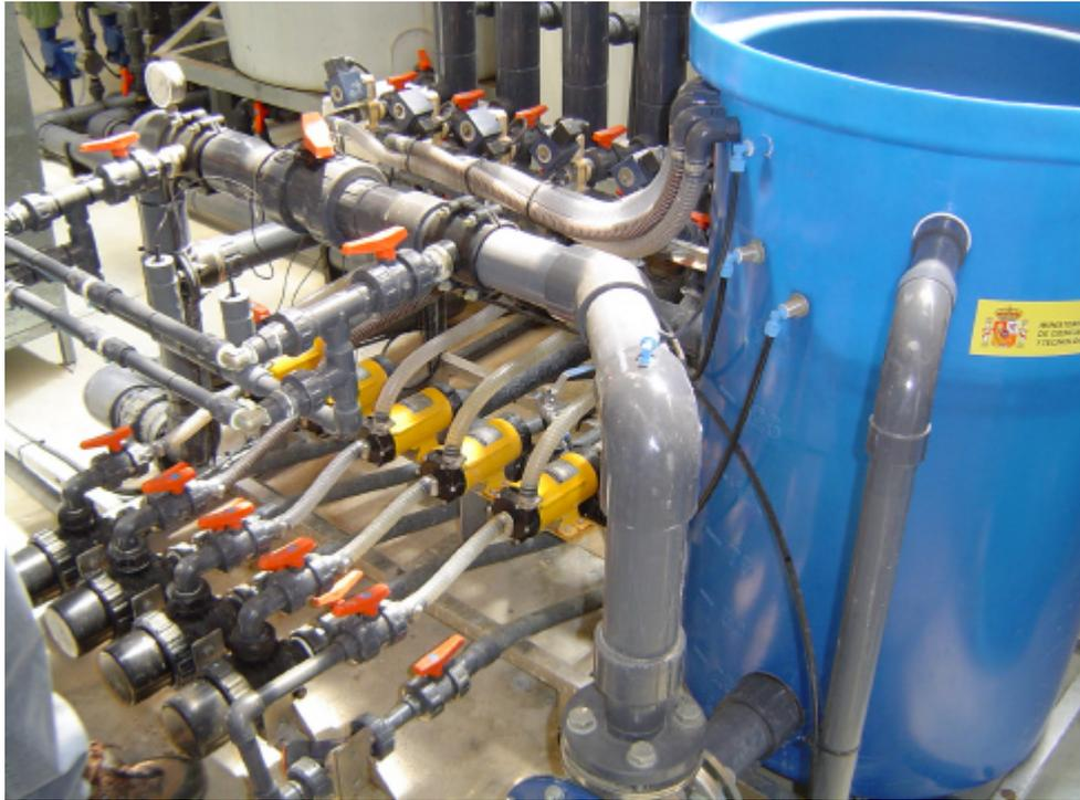
Figura 16: Cabezal de riego
