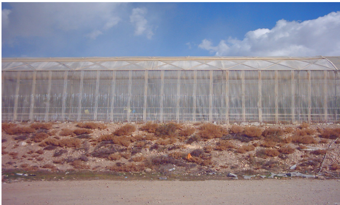
Lateral del multitúnel tipo policarbonato
