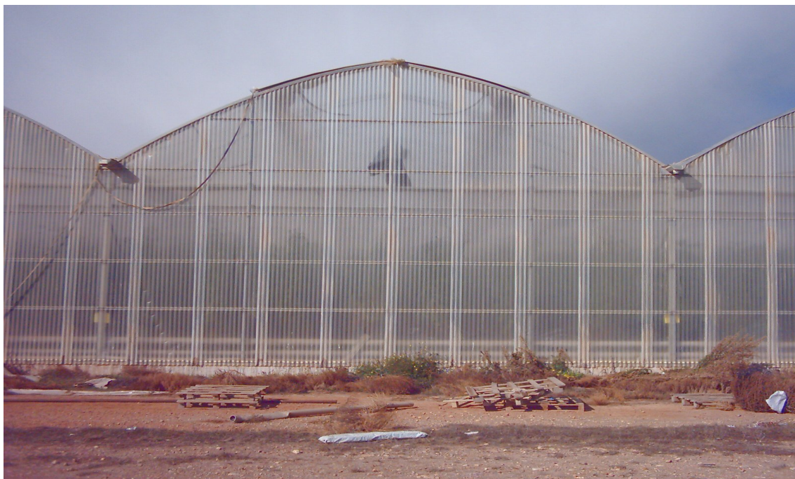
Frontal del multitúnel tipo policarbonato (éste es ojival, yo simularé el tipo arco)
