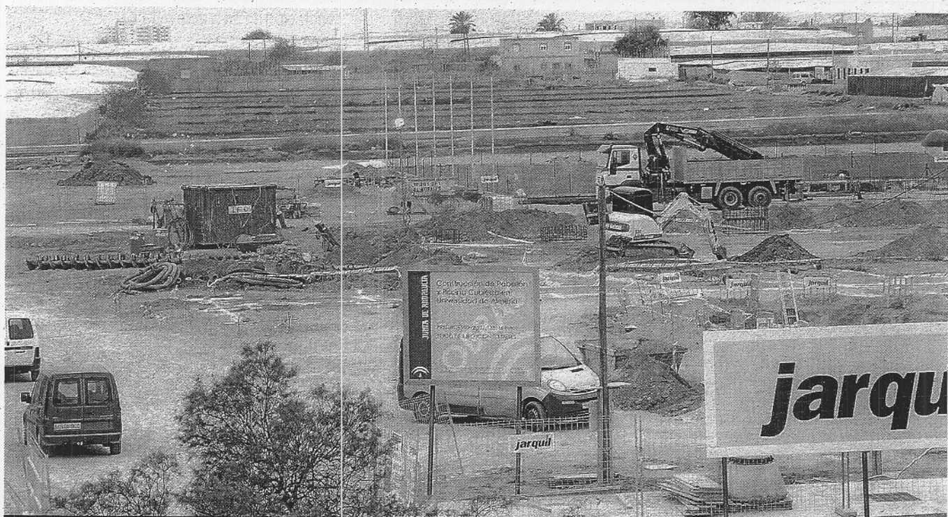
TRABAJOS. Varias máquinas trabajan en las obras de construcción del futuro complejo deportivo. / PRENSA UAL
