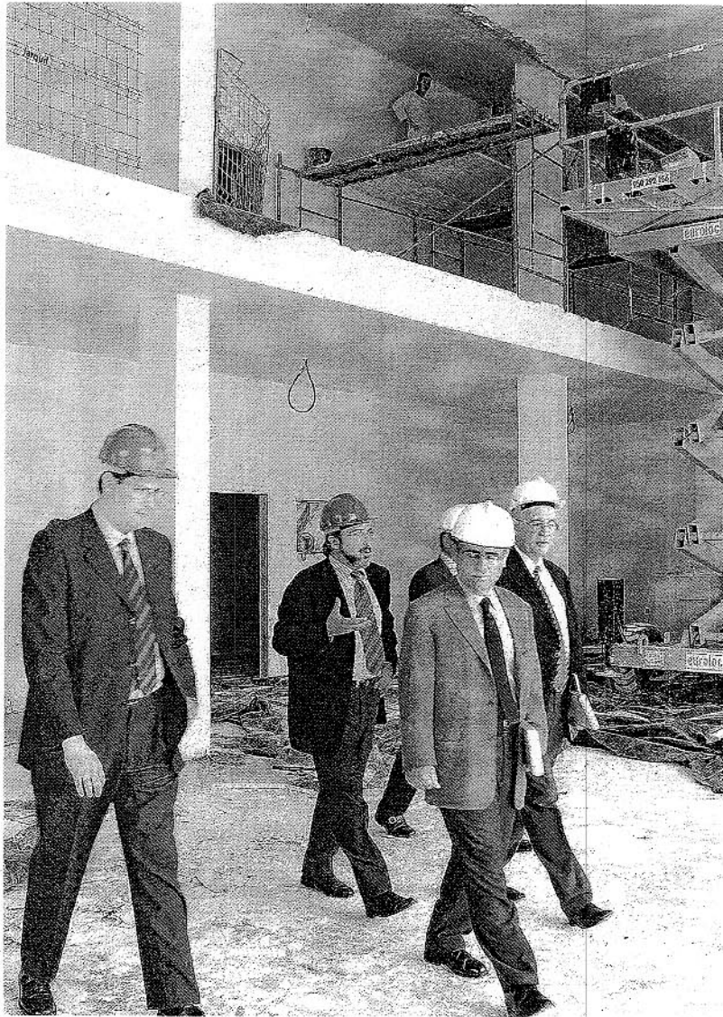
INSTALACIÓN. Obras del Centro en el Campus de La Cañada. / PRENSA UAL
