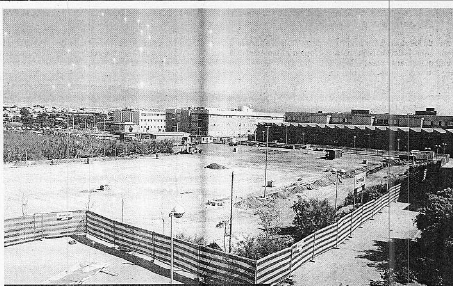
TRABAJOS. Imagen del futuro edificio, actualmente en obras. / P. U.
