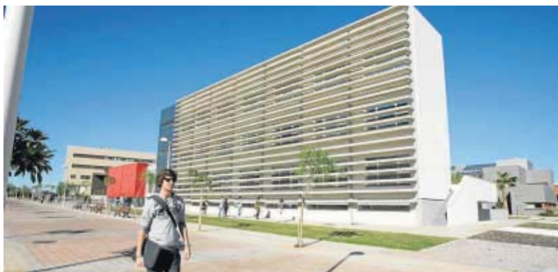
Edificio Científico Técnico de Informática y Comunicaciones (CITIC).
